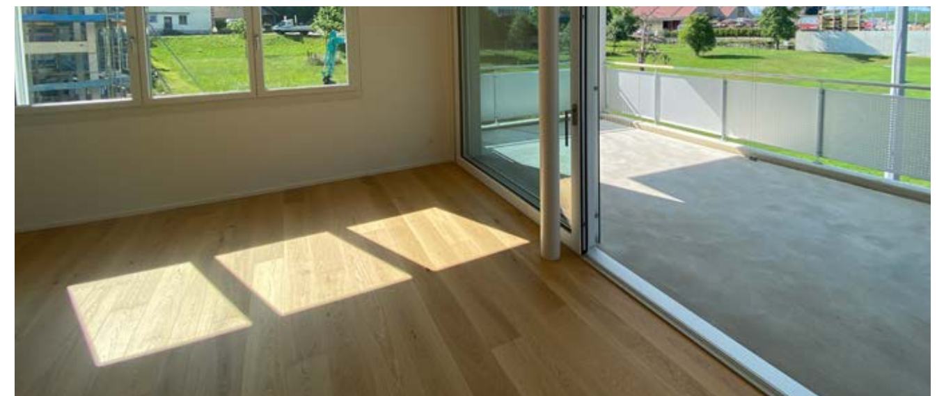
Sicher und komfortabel Schwellenlose Hebeschiebetüre
